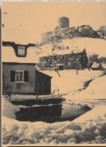
Löschweiher an der Eichenstraße (Weihelass Damm) in Burgthann
