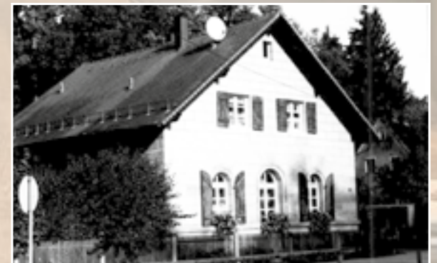
Kurzzeitig bewohnten die Familie Werner auch das Kanalhaus an der Schleuse 34
