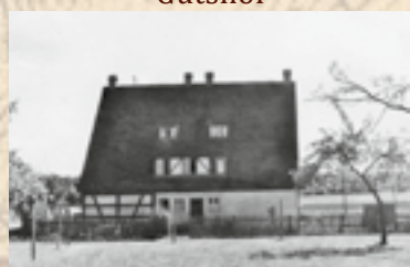
ehemalige Scheune und Pferdestall
