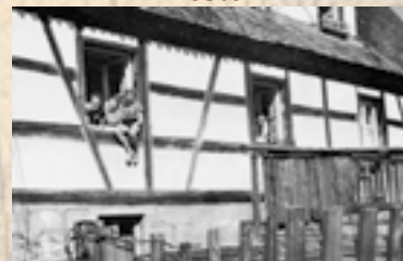
Das ehemalige Gesindehaus - wurde abgerissen
