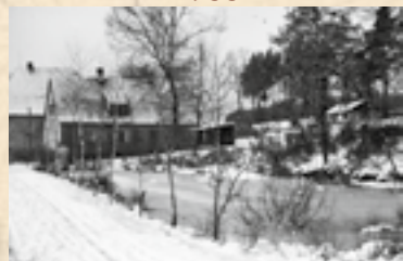
Blick von Osten auf den Gutshof
